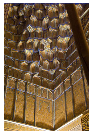
Pas d'image humaine, mais un foisonnement décoratif. Ici, transition murs/plafonds « en nid d'abeilles » (muqarnas) Nécropole Gour Emir (Samarcande, Ouzbékistan)
