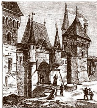
PORTE FORTIFIÉE. Les portes fortifiées de la ville sont munies de pont-levis jetés sur les fossés qui entourent les remparts; le soir on lève les ponts, on ferme les portes en nul ne peut entrer dans la ville – La petite ville de Phalsbourg a été fortifiée par Vauban. Traversée par la route de Paris à Strasbourg, elle n'a que deux portes: la porte de France à l'ouest, et la porte d'Allemagne au Sud-Est, qui sont des modèles d'architecture militaire.
